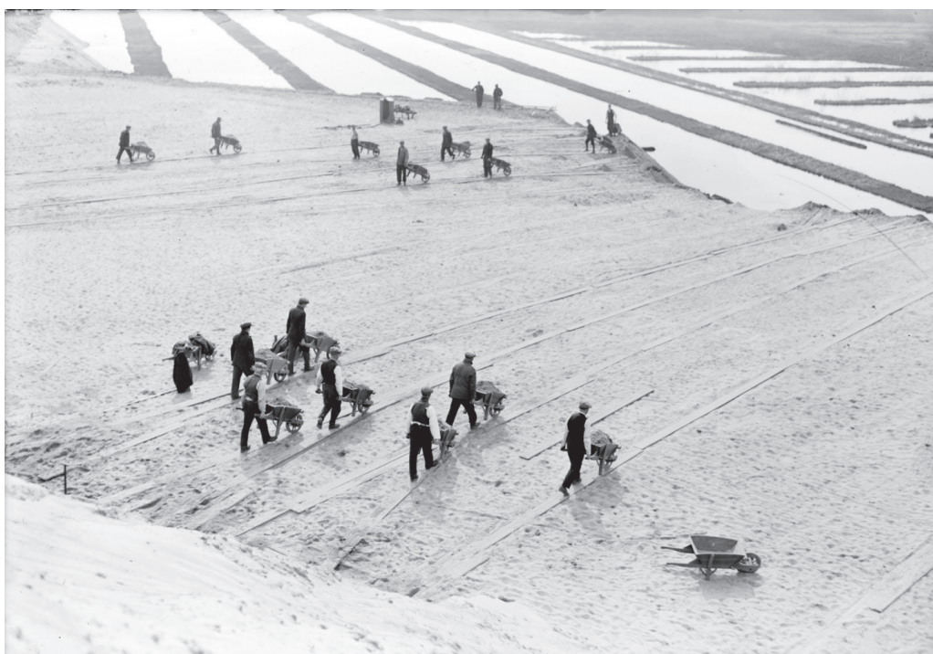
Afbeelding 3. Werkloze arbeiders kruien in het kader van de werkverschaffing zand om in 's-Hertogenbosch ten westen van het spoor het terrein op te hogen ten behoeve van de industrie (1934). Foto: Erfgoed 's-Hertogenbosch, GAHt 0025911, Fotopersbureau Het Zuiden.
