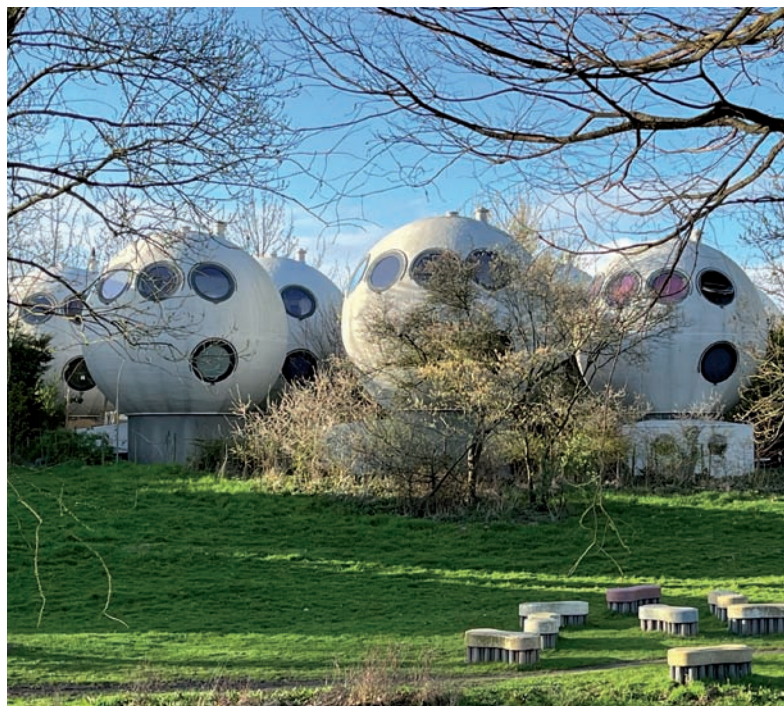
De Bossche bolwoningen anno 2024 (foto Erfgoed 's-Hertogenbosch/auteur).
