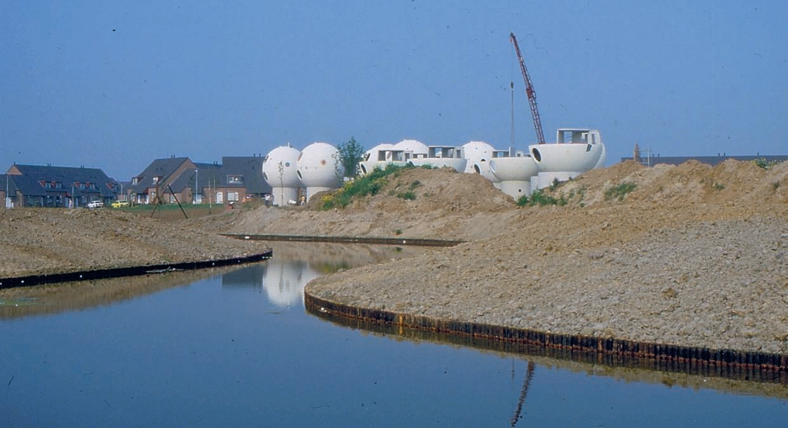
Bolwoningen in aanbouw, de prefab wand- en vloerdelen zijn goed zichtbaar, de geplande slingerende vijver is al aangelegd, 1984 (NL-HtSA, fotocollectie, nr. 0086658).
