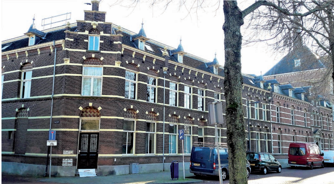
Rechts het gebouw van de Van Lanschot Stichting en links het woonblok dat in 1911 werd gebouwd. Aanvankelijk bestond het blok, met iets donkerder kleur steen, uit drie woningen. Rond 1957 werd dit complex onderdeel van de Mariënborg, maar het werd later verbouwd tot boven- en benedenwoningen (foto auteur, februari 2023).
