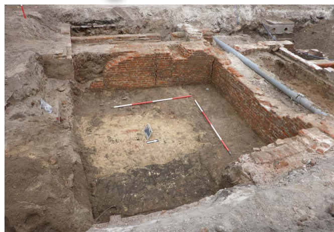
Fundering van een groot stenen huis uit het begin van de 15de eeuw aan de Binnendieze op het terrein van het latere Groot Ziekengasthuis. Het is onduidelijk of het op één van de percelen stond die na 1423 zijn uitgegeven of dat het er toen al stond. (foto Erfgoed 's-Hertogenbosch)
