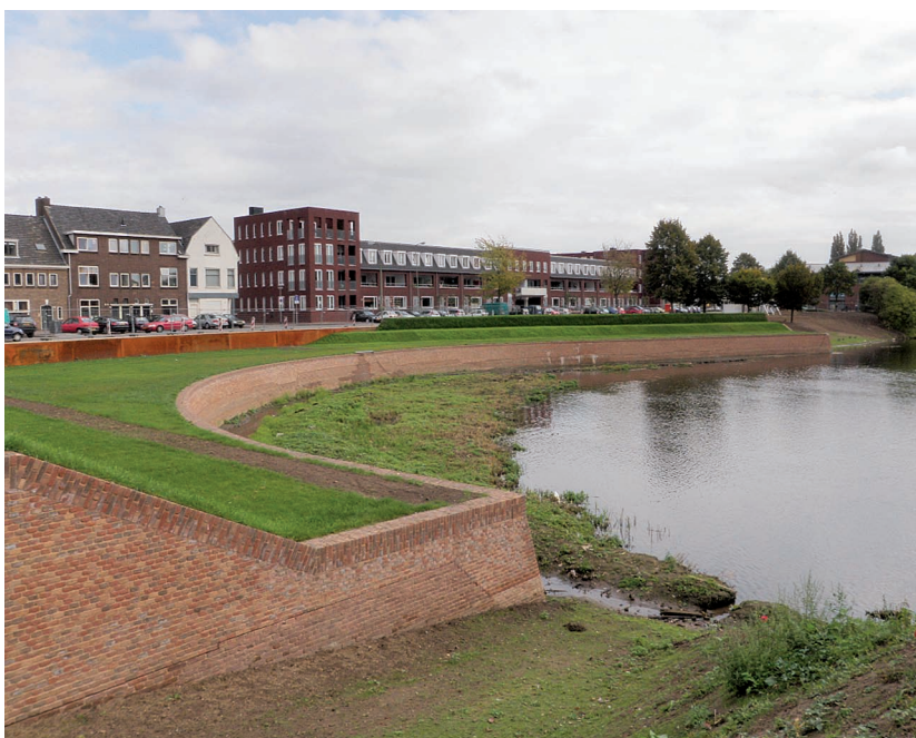
Boven: De ronding van de keelmuur en de 'uitbouw' met de trap. Deze heeft lichtgebogen treden. De bovenste drie van de in totaal dertien treden ontbreken. De linkerhoek van de trap is tot de oorspronkelijke hoogte bewaard gebleven. Dit was dus tevens de hoogte van het 'terreplein' en de aanlanding van de houten brug. (Foto: BAM)
