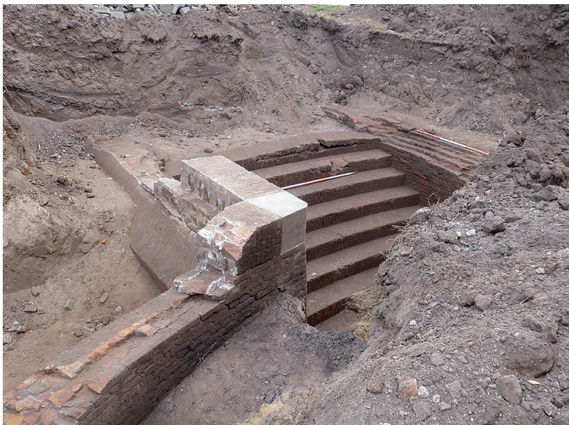
Boven: De ronding van de keelmuur en de 'uitbouw' met de trap. Deze heeft lichtgebogen treden. De bovenste drie van de in totaal dertien treden ontbreken. De linkerhoek van de trap is tot de oorspronkelijke hoogte bewaard gebleven. Dit was dus tevens de hoogte van het 'terreplein' en de aanlanding van de houten brug. (Foto: BAM)
