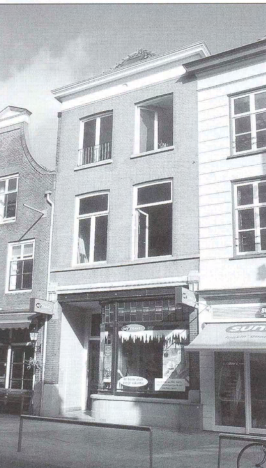
Gevel Hinthamerstraat 84-86. (Foto: BAM)
