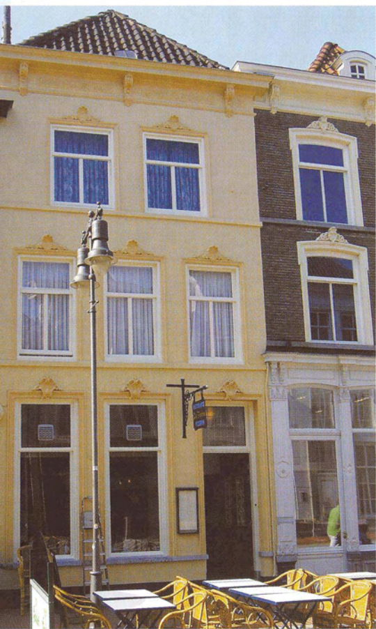
Gereconstrueerde gevelafwerking Kerkstraat 77. (Foto: BAM)
