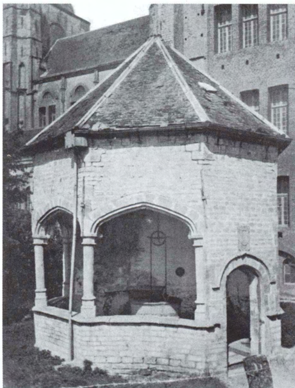
Puthuis Veere vóór de restauratie (Uit: F.A.J. Vermeulen, 'Handboek tot de Geschiedenis der Nederlandsche Bouwkunst', 's-Gravenhage 1931, plaat 394)
