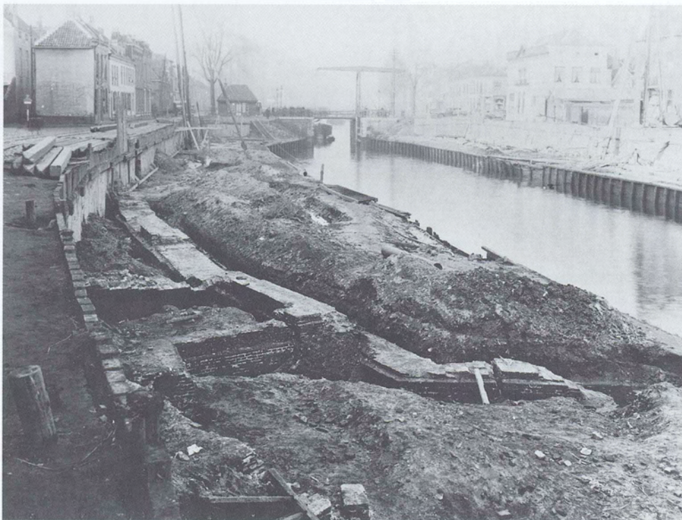
Situatie van de muurresten op 13 december 1932 (Foto: archief Rijkswaterstaat, Directie Noord- Brabant)
