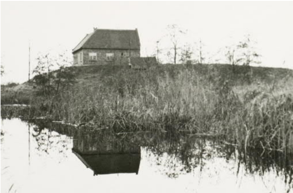
Situatie tussen 1950 en 1960 (foto J.A.M. Roelands, collectie Erfgoed 's-Hertogenbosch 0004772)
