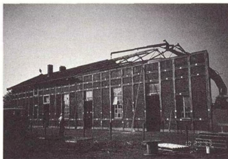
Afb. 6 De loods tijdens de demontage op 29 oktober 1993 (foto: BAD).
