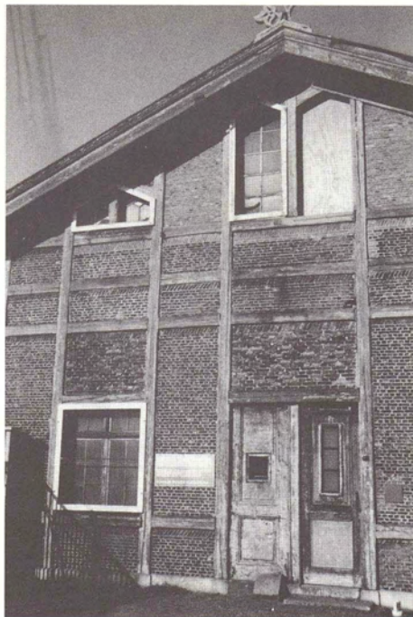
Afb. 3 Zuidgevel van de loods met de houten deur en de stucwerk namaak-deur. Op de nok het restant van de houten palmet. Situatie 1989 (foto: Bouwhistorische en Archeologische Dienst 's-Hertogenbosch, BAD).
